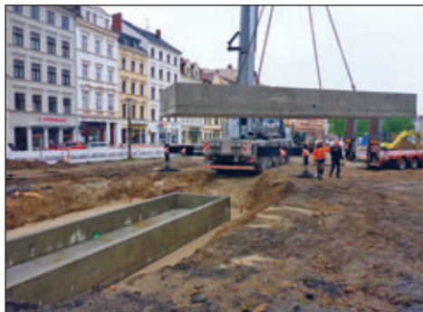
Die Zisternen wurden am 10. April auf dem Elisabethplatz eingebaut.
